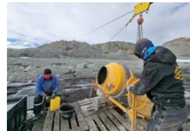
Възведена линия изкачва до хълмиста местност бетона, необходим за фундаментните стъпки за новата лаборатория
